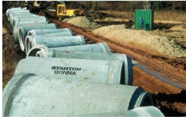
Beton borular inşaat sahasında özel bir koruma gerektirmez
