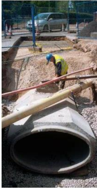
Elipitik boru; çok az kazı derinliğinde doğalgaz borusu altında
